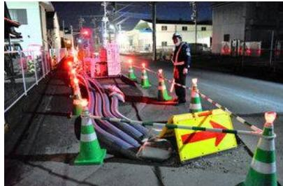
陥没地点の水位を下げるための下水道管のバイパス
